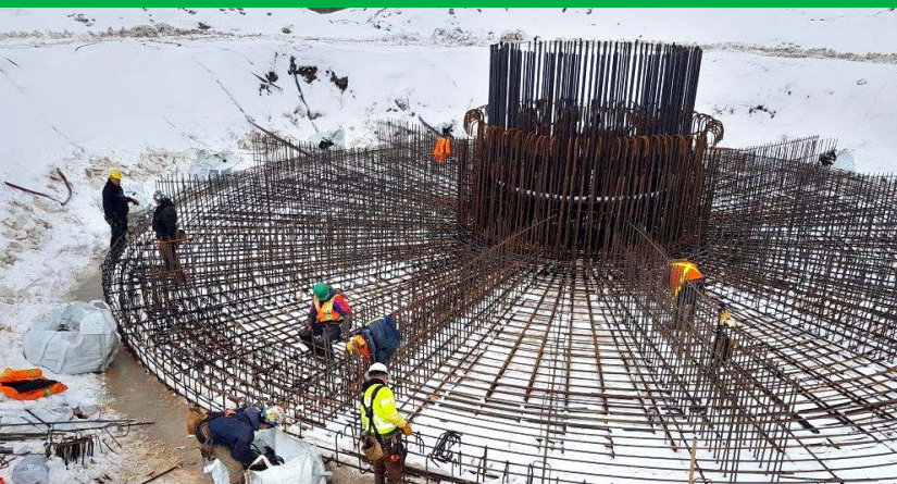
Des membres de l'équipe B&M construisent une base de turbine sur place à Riverside-Albert, au Nouveau-Brunswick.
