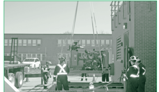
Au haut, la raffinerie IOL à Dartmouth; ci-dessus, l'équipe B&M installe une nouvelle génératrice.
