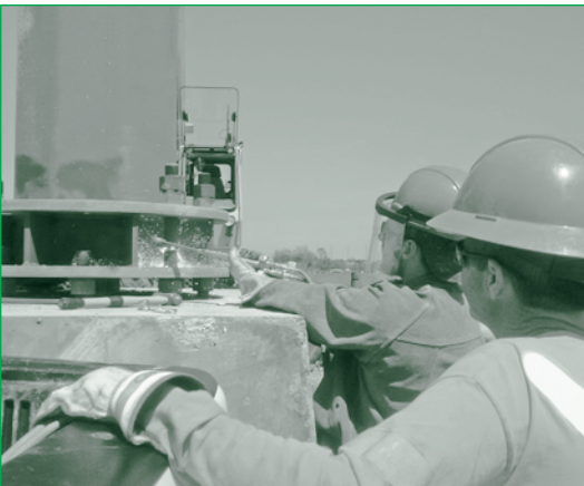
Installation d'éclairage sur mâts – autoroute 407 Est
